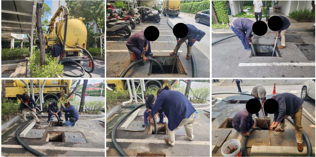
รูปที่ 2-41 สืบสิ่งปฏิกูลและดูดไขมัน เมื่อวันที่ 15 ตุลาคม 2567
