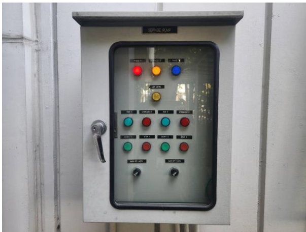
รูปที่ 2-12 ตู้ควบคุมระบบบำบัดน้ำเสีย
