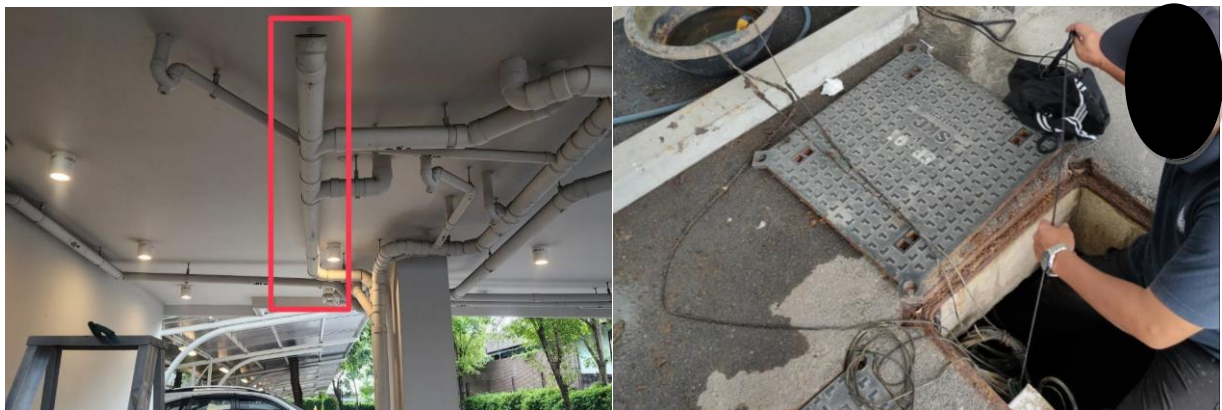
รูปที่ 2-33 ตรวจสอบและทำความสะอาดท่อระบายน้ำ
